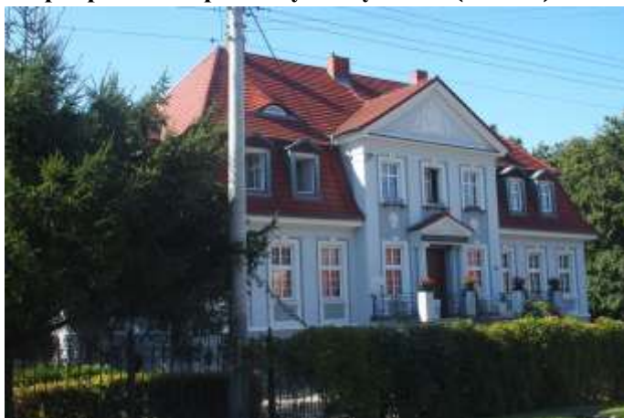
Zdjęcie nr 9. Pałac w Bądzowie (nr 30A)
