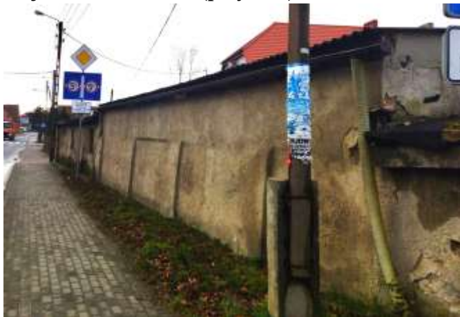
Zdjęcie nr 11. Stajnia w Kurowicach (przy nr 7)
