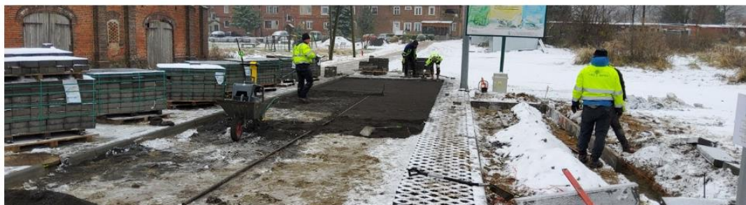
Ulica Maniów w budowie
