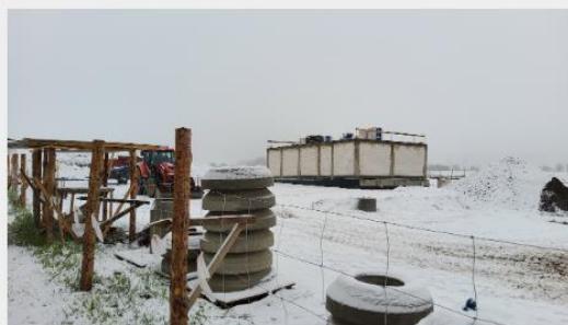
Postęp prac na budowie kompleksu zimą 2021 r.
